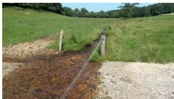
Passage à gué aménagé sur la Briance
