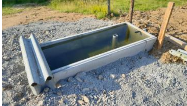
Aménagement d'un abreuvoir gravitaire sur la Breuilh
